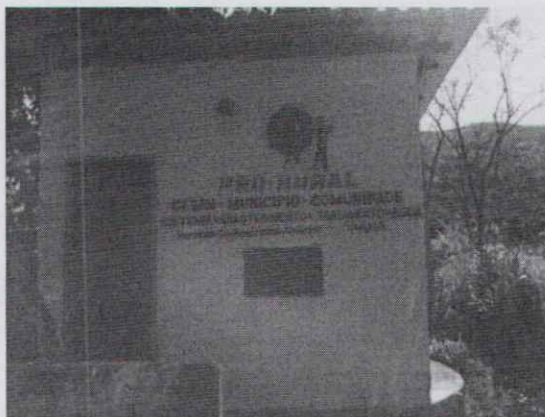
Figura 3-55 - Instalações do Pró-Rural de Perobas.
