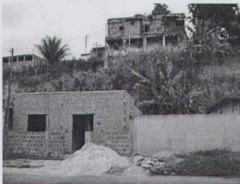
Figura 3-25 - Casas ameaçadas por outras devido ao talude mal executado. Marcílio de Noronha, Viana-ES.
