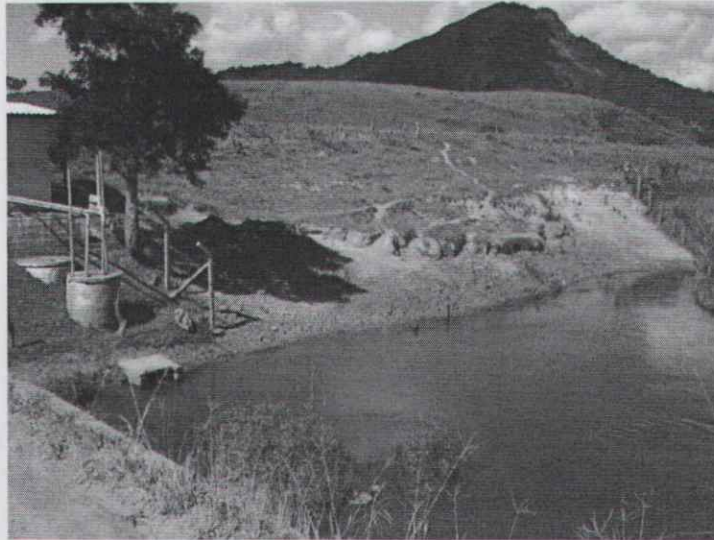
Figura 3-49 - Captação de água bruta no Rio Jacarandá.
