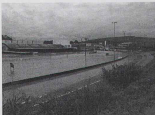
Figura 3-18 - Alagamento na BR 262, Viana-ES.
