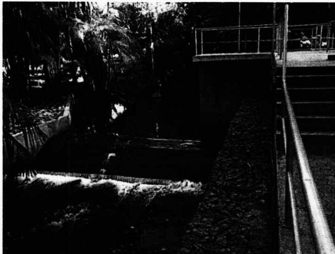
Figura 3-53 - Captação de água bruta no Rio Santo Agostinho.
