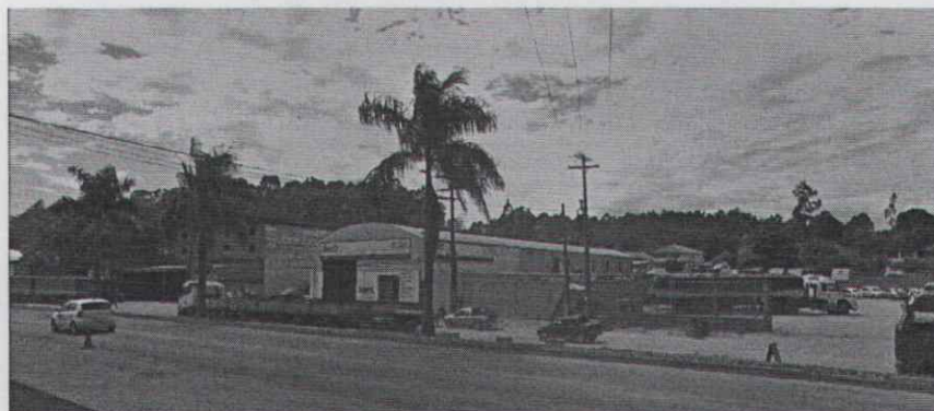
Figura 3-6 - Rodovia 262, Bairro Parque Industrial, Viana-ES.
